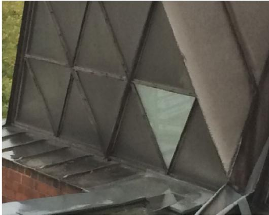
Im Oktober konnte endlich die Bautechnik für unsere umfassende Sanierung der mehr als 300 Dachfenster geklärt werden: Ein defektes Einfachfenster von 1960 wurde durch ein Iso-Fenster ersetzt, dessen Glas die gleiche Struktur hat, wie das Originalfenster. Das deutlich dickere Glas konnte ohne Probleme eingebaut werden und ist damit das Muster für die Gesamtarbeiten im nächsten Frühjahr, bei denen – und das steht jetzt auch fest – kein Gerüst im Innern der Kirche aufgestellt werden muss.
